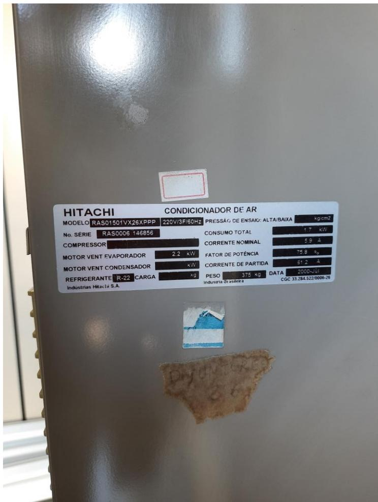
Foto 5.2.1.12 – Especificação Evaporadora Edifício Anexo I.
