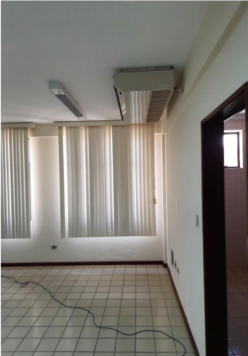
Foto 5.2.1.6 – Equipamento Existente – Piso Teto instalado no 3º Pav. Ed. Sede
