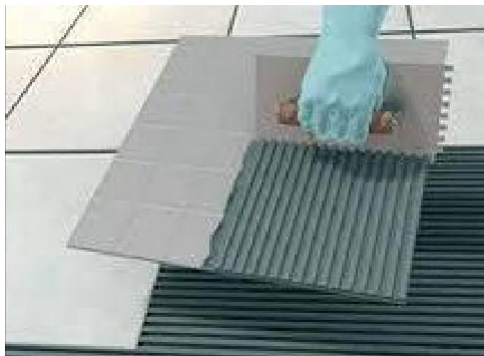
Aplicação cola na cerâmica: Google
