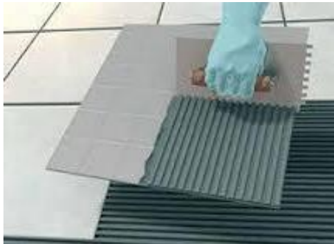
Aplicação cola na cerâmica: Google
