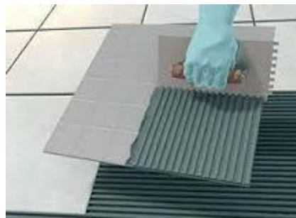
Aplicação cola na cerâmica: Google
